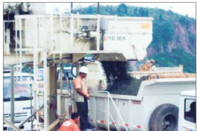
FIGURA 3 VISTA DO MISTURADOR E CARREGAMENTO DO CONCRETO
