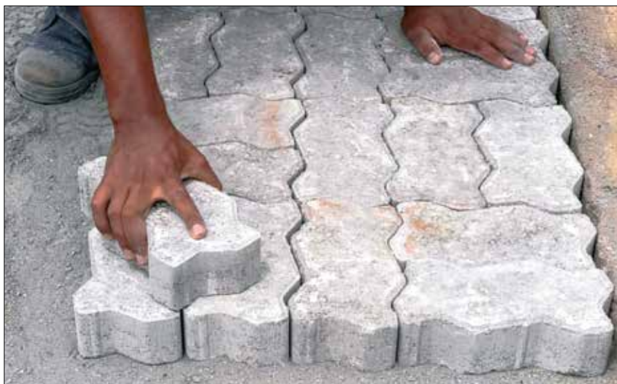
Assentamento de pisos intertravados de 16 faces
