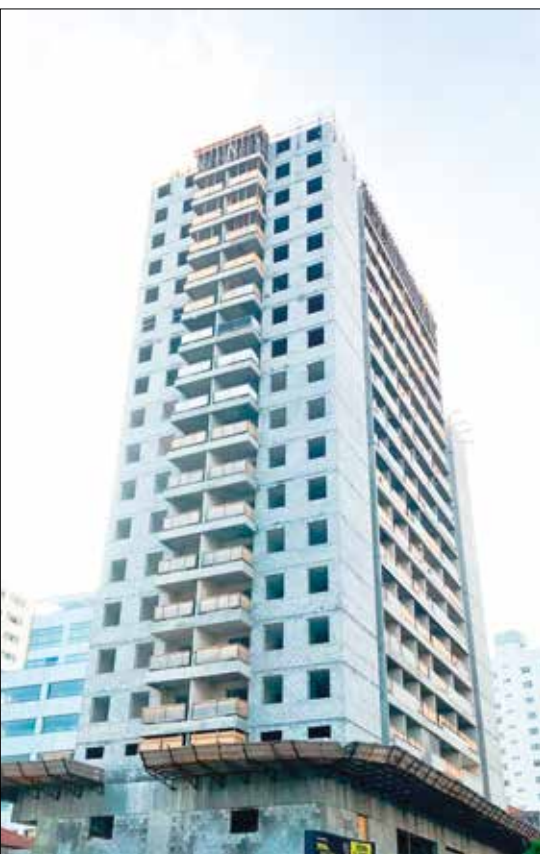
Edifício na Avenida Rebouças em Alvenaria Estrutural
