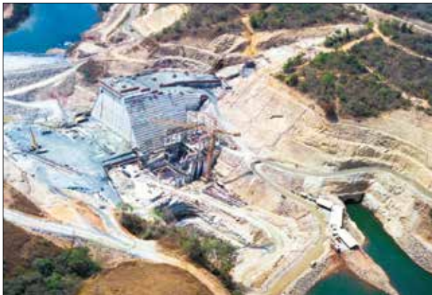
FIGURA 3 BARRAGEM DE CCR – UHE SERRA DO FACÃO
