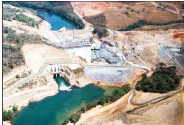
FIGURA 4 BARRAGEM DE CCR E TÚNEL DE DESVIO
